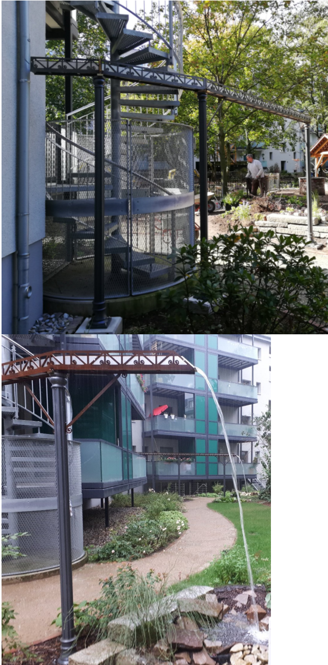
Bild 2-6: Oberirdische Zuleitung vom Fallrohr zu einem Teich mit Uferversickerung (Quelle: aquaplaner, ISAH)
