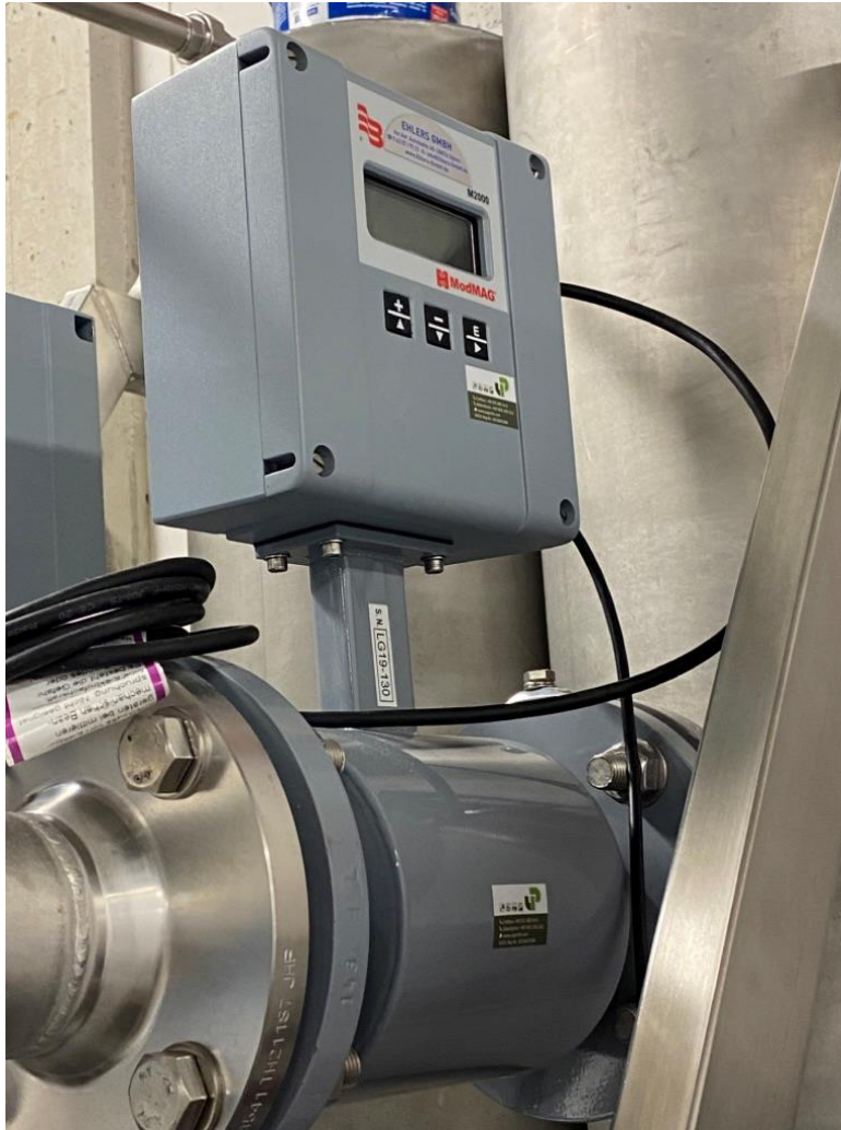
Bild 11: MID der Abflussmessvorrichtung [Quelle: LHH, eigenes Foto]
