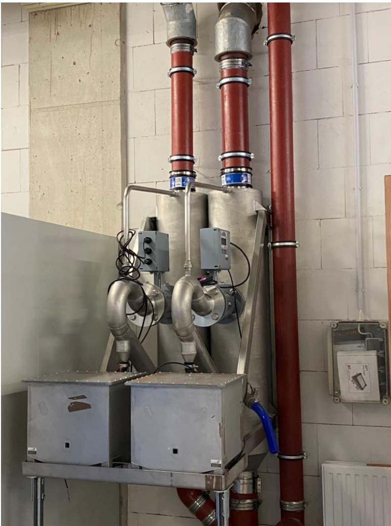
Bild 10: Eingebaute Abflussmessvorrichtung [Quelle: LHH, eigenes Foto]
