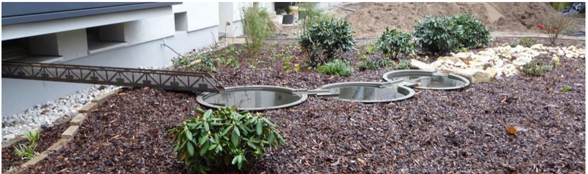
Abbildung 8: Zisternen-Kaskaden-System im umgestalteten Innenhof der Wohnungsgenossenschaft Gartenheim, Bildquelle: ISAH
